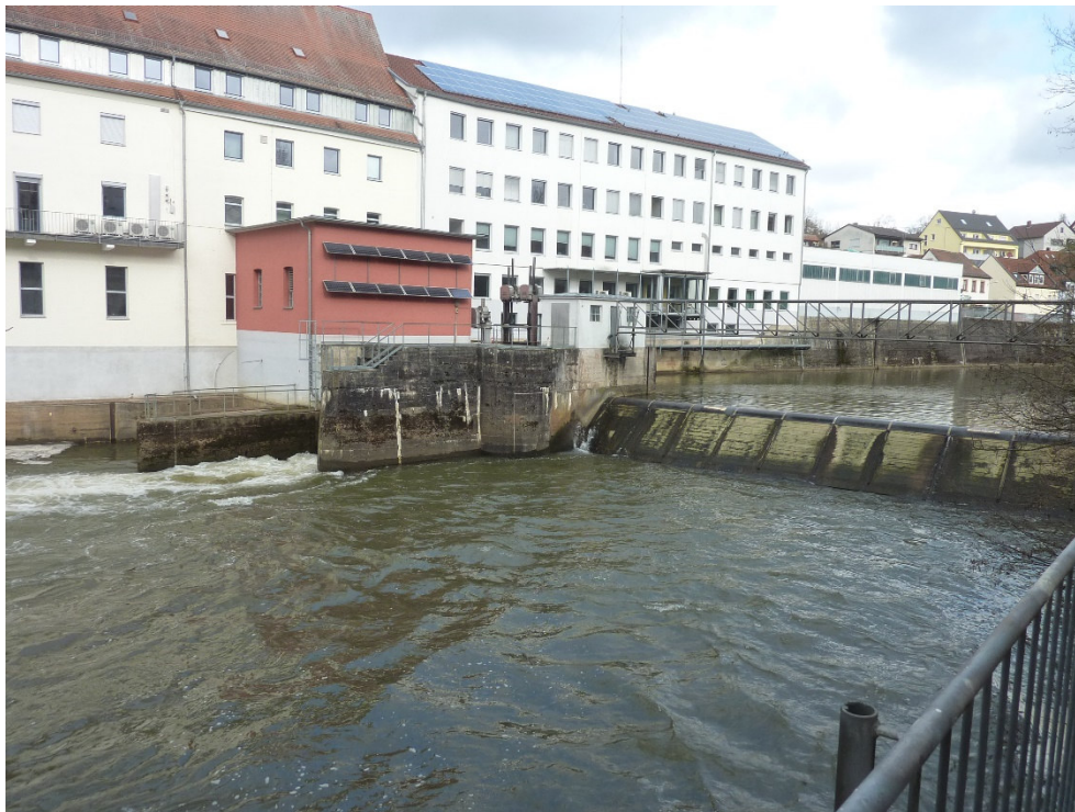
Abb. 3: Wehr Stadtwerke Lauf und massiver Uferverbau in Lauf a. d. Pegnitz
