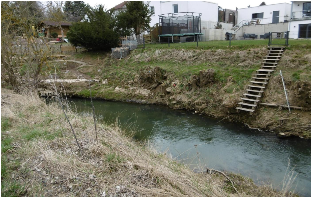
Stark eingetiefter Bereich im Ortsbereich Weiher
