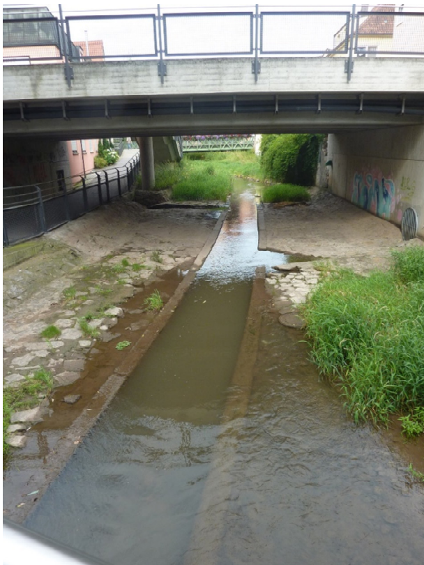
Abb. 4: Verbautes Gewässerprofil Stadtgebiet Schwabach bei FKM 3,7
