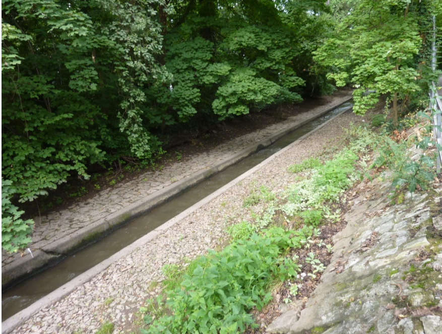
Abb. 5: Verbautes Gewässerprofil Stadtgebiet Schwabach bei FKM 3,6
