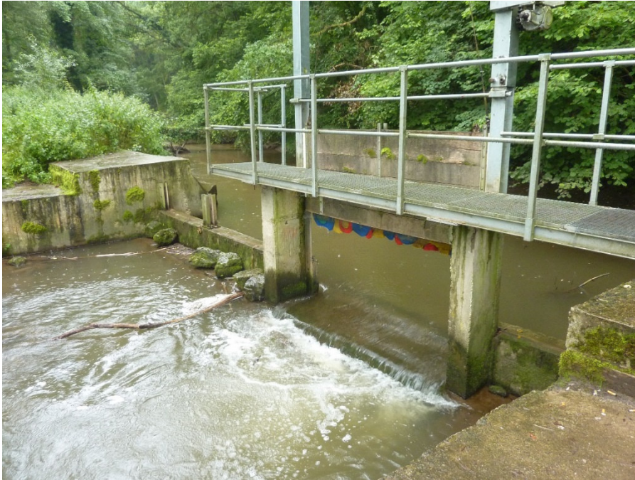
Abb. 7: Wässerwehr an der Schwabach bei FKM 0,25
