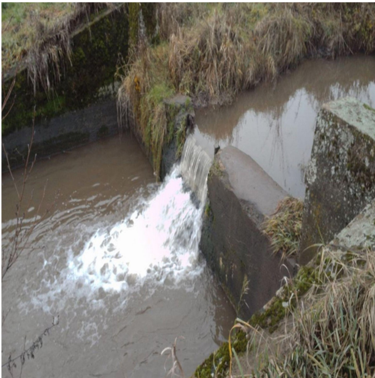
Abb. 8: Ausleitungswehr für den Nadlersbach bei FKM 7,0
