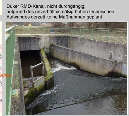
Düker RMD-Kanal, nicht durchgängig; aufgrund des unverhältnismäßig hohen technischen Aufwandes derzeit keine Maßnahmen geplant
